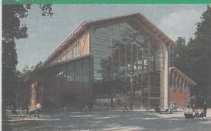
Hangar Y, vue Nord, la serre, octobre 2022
